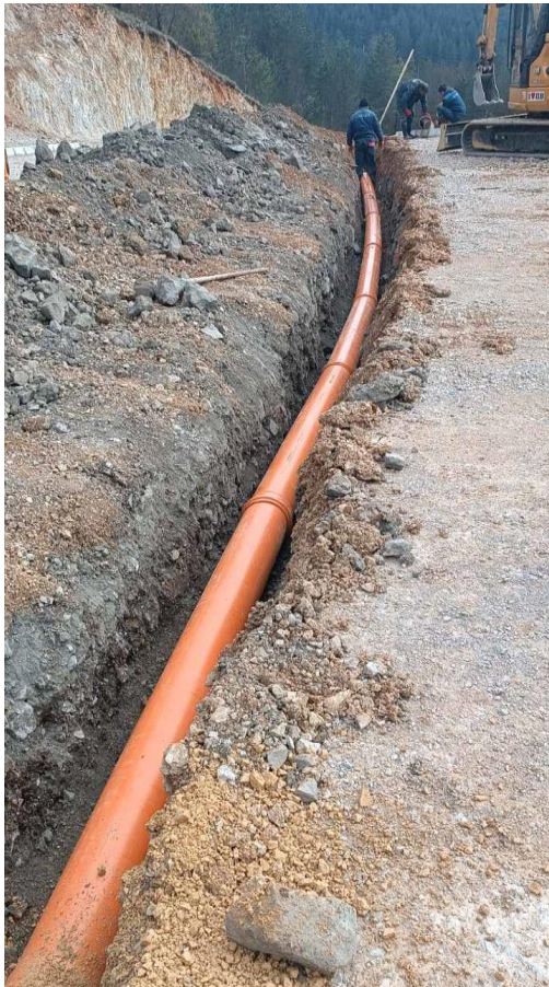
Slika br.12. Radovi na izgradnji atmosferske kanalizacije na platou manastira Svete Trojice
