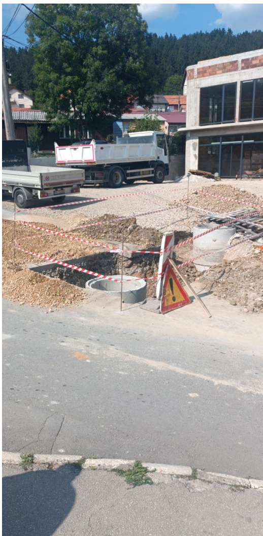
Slika br.6. Radovi na izgradnji vodovodnog priključka i priključka za fekalnu kanalizaciju na stambeno-poslovnom objektu u Lovćenskoj ulici
