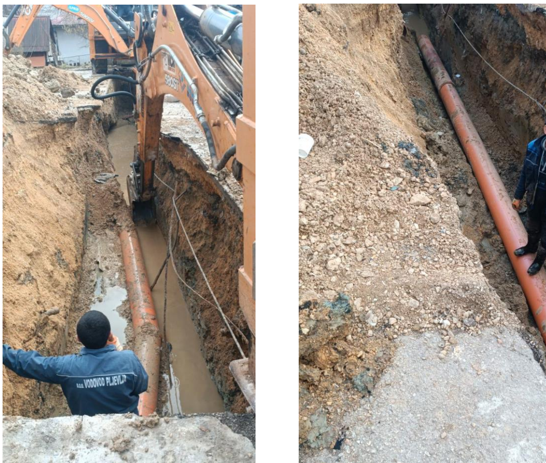
Slika br.11. Radovi na razdvajanju atmosferske i fekalne kanalčizacije u Vlolođinoj ulici (naselje Kupusište)
