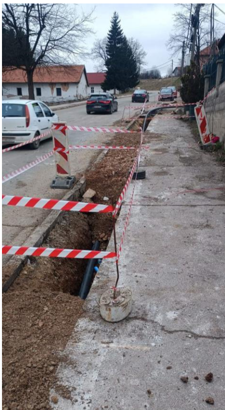
Slika br.3. Rekonstrukcija vodovodne mreže i izgradnja fekalne kanalizacije u dijelu ulice Serdara Janka Vukotića (od objekta Radulović prevoza do restorana Apolon)
