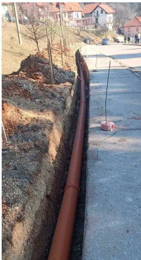
Slika br.2. Rekonstrukcija vodovodne mreže i izgradnja fekalne kanalizacije u dijelu ulice Serdara Janka Vukotića (od Monaka do objekta Radulović prevoza)
