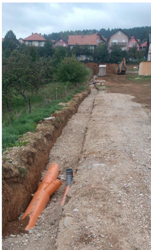
Slika br.7. Radovi na izgradnji vodovodne i kanalizacione mreže u dijelu Jadranske ulice
