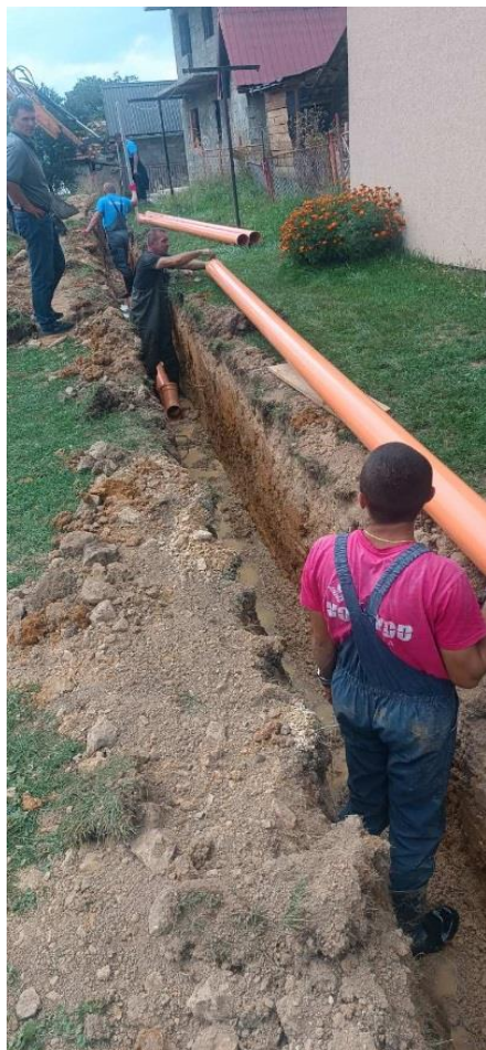
Slika br.9. Radovi na izgradnji fekalne kanalizacije u ulici Deveta
