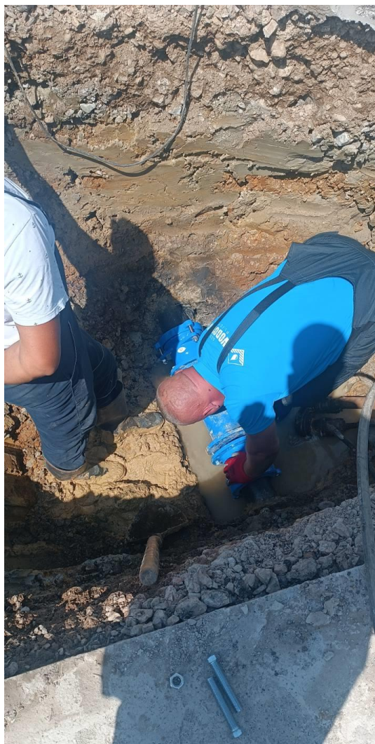
Slika br.6. Radovi na izgradnji vodovodnog priključka i priključka za fekalnu kanalizaciju na stambeno-poslovnom objektu u Lovćenskoj ulici
