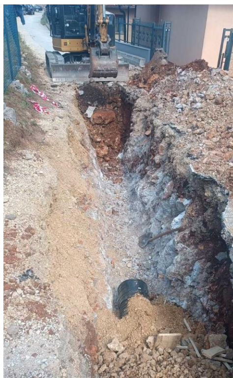
Slika br.14. Radovi na izgradnji atmosferske kanalizacije u dijelu ulice dr Slobodana Dragaševića (od raskrsnice sa ulicom Jadranska do raskrsnice sa Šavničkom ulicom)
