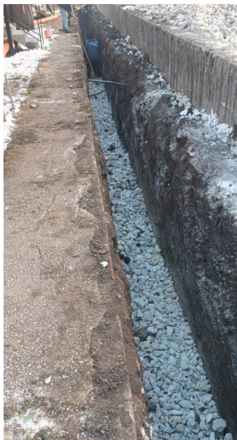
Slika br.10. Radovi na izgradnji atmosferske kanalizacije i drenaže u ulici II Proleterske (iza zgrade GM3)
