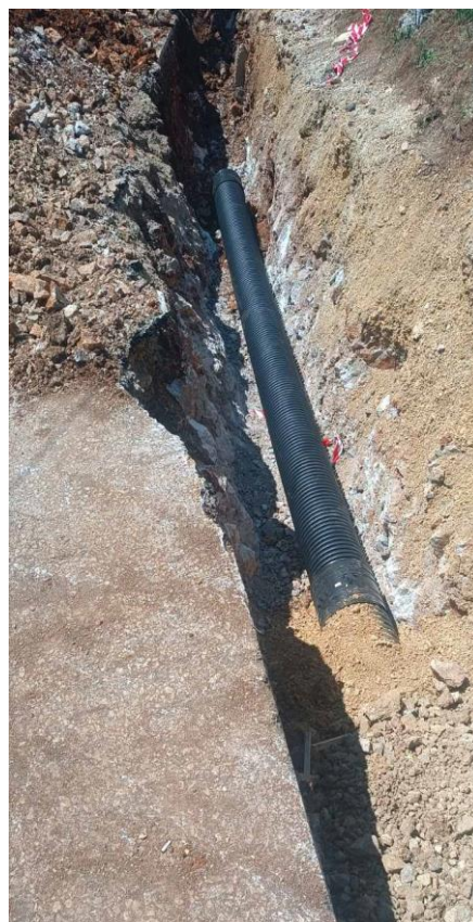
Slika br.5. Radovi na izgradnji atmosfere kanalizacije u ulici dr Slobodana Dragaševića (od raskrsnice sa ulicom Save Kovačevića do raskrsnice sa Šavničkom ulicom)
