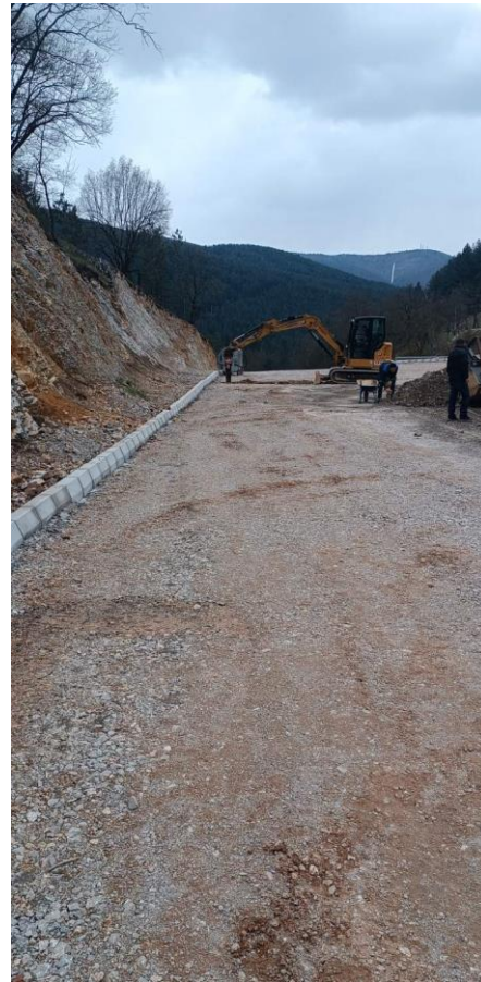
Slika br.12. Radovi na izgradnji atmosferske kanalizacije na platou manastira Svete Trojice
