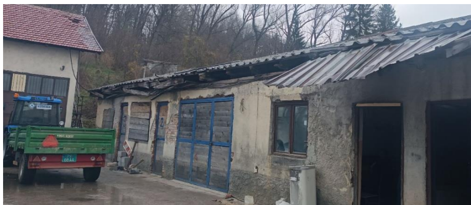
Objekat pogona DOO "VODOVOD" Pljevlja
