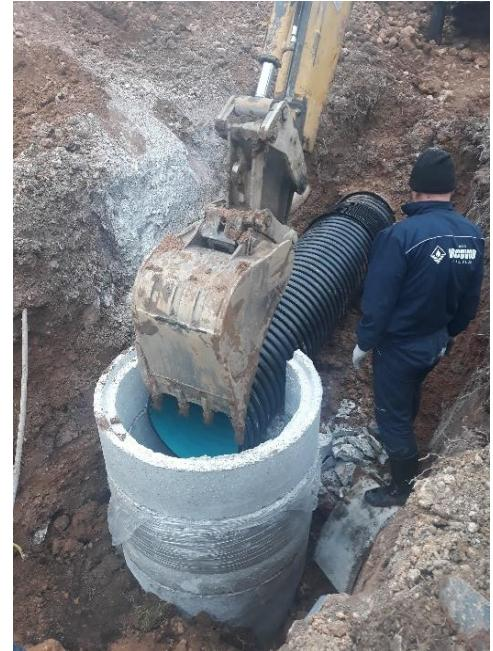
**Skica br. 5. Situacija –izvedeno stanje –izgrađeni kišni kolektor u naselju Dolovi II i slike radova na izgradnji kišnog kolektora**
