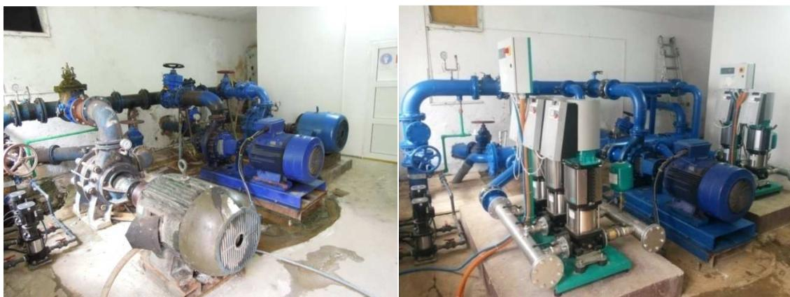
Slika 1. Pumpno postrojenje na PS „Breznica“ prije i nakon izvedenih radova na sanaciji
