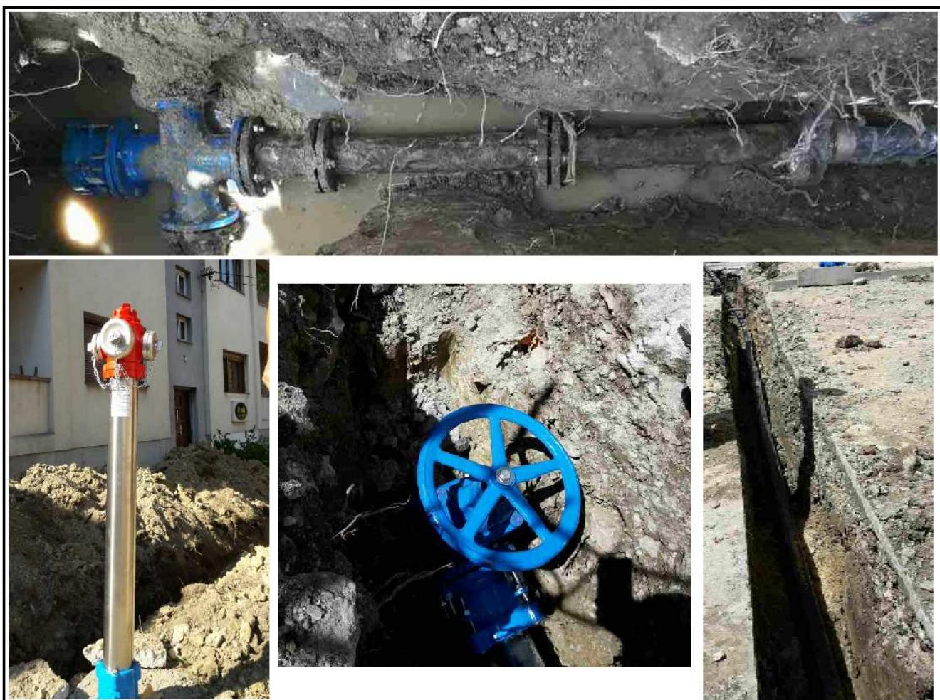
*Slika br.2 – Prikaz novougrađenih vodovodnih cijevi, fazonskih komada
