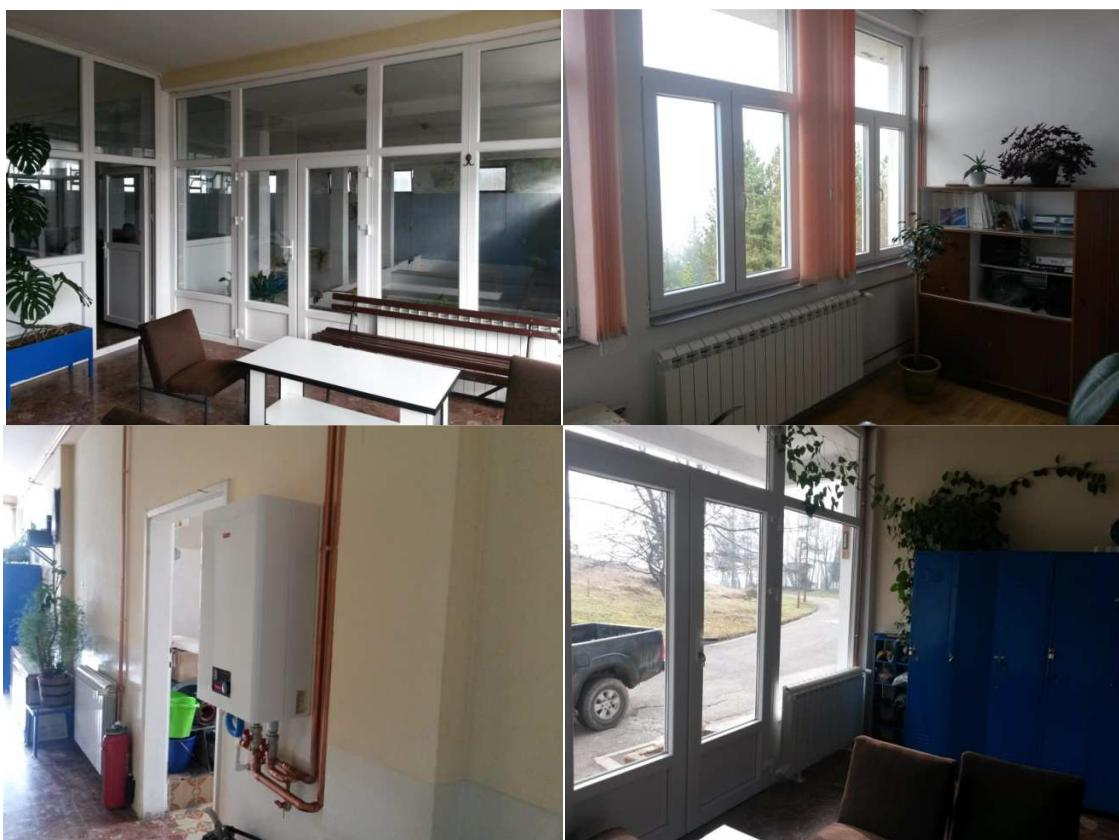
*Slika br.3 Nova bravarija i sistem centralnog grijanja na PPV "Pliješ"*
