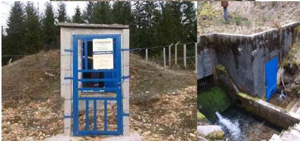
Radovi na sanaciji kaptaža: Zmajevac, Mandojevac, Bezarska Vrela
