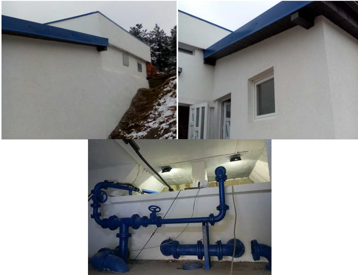
Rezervoar „Bogiševac“ nakon izvedenih radova na rekonstrukciji
