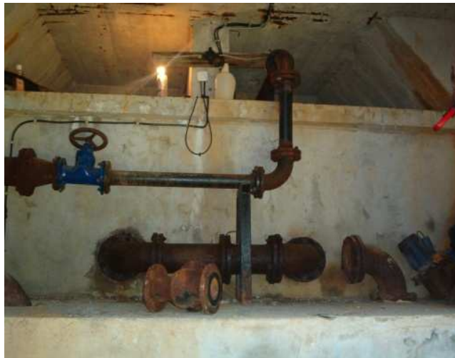
Rezervoar „Bogiševac“ - prije izvedenih radova na rekonstrukciji
