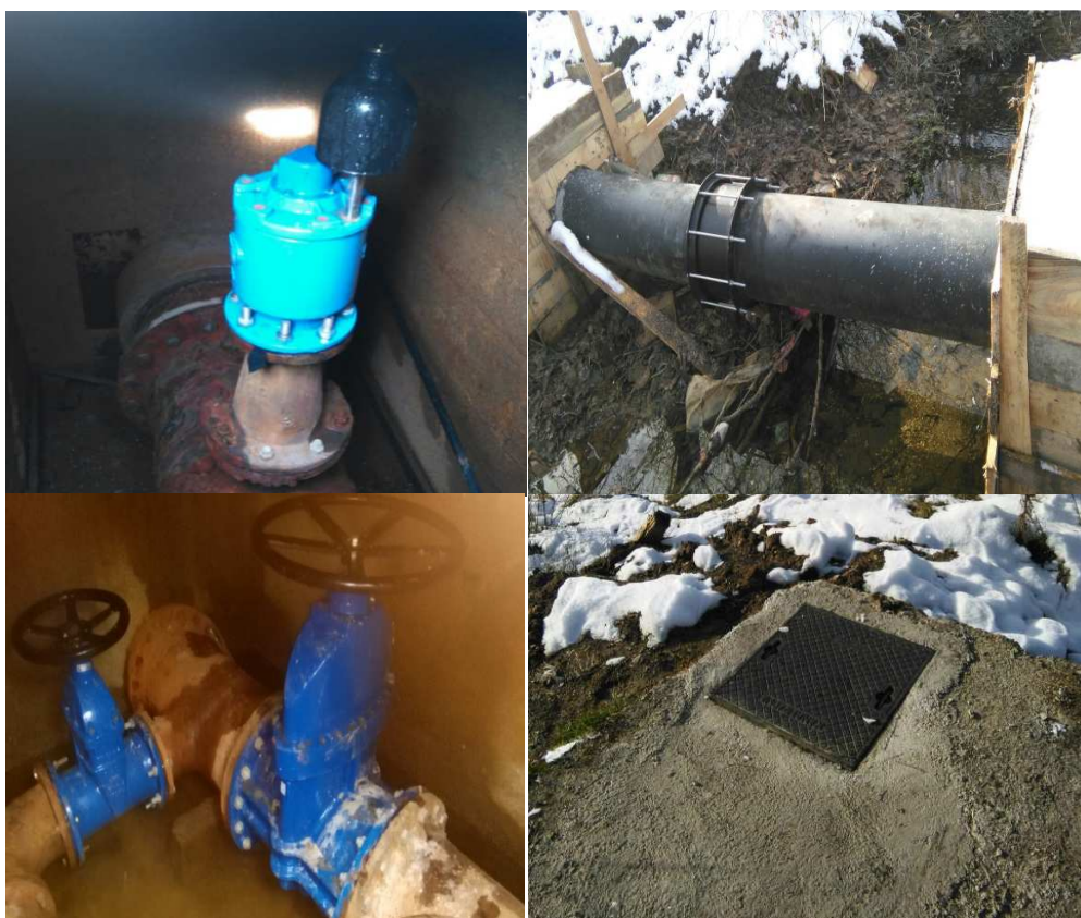
Radovi na sanaciji glavnog dovodnog cjevovoda Odžak – Pliješ (zamjena vazdušnih ventila i zatvarača, sanacija kvarova, sanacija šahtova i zamjena šahtnih poklopaca)
